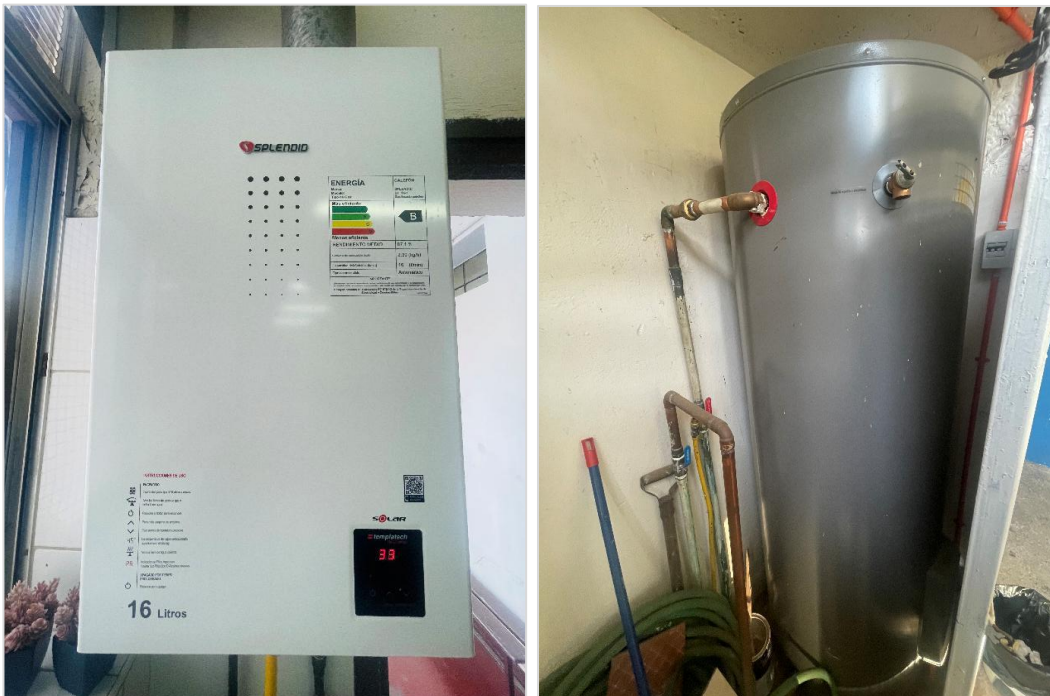
Figura 52: Calefont y termo eléctrico existente en el liceo
