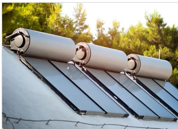
Figura 50: Ejemplo de sistema solar térmico para agua caliente sanitaria
