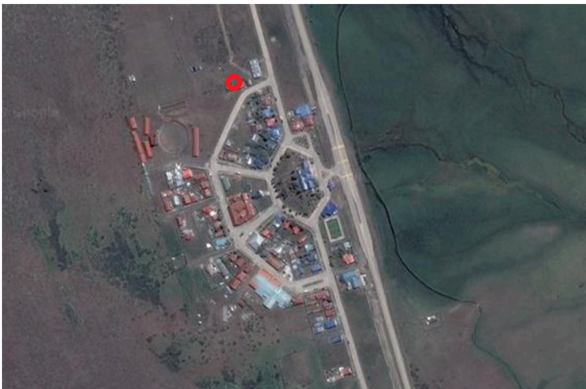
Figura 9: Caseta de generadores Villa Tehuelches.
